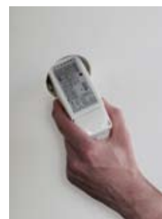
5) Montering av LCC30 i ett 70 mm hål.
